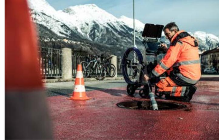
**Wir finden jeden noch so kleinen Schaden**, der vor oder im Zuge eines Bauvorhabens entstanden ist und das Kanalsystem beeinträchtigen könnte! Denn wenn in der Nähe von Kanälen Bauarbeiten – egal ob Hoch- oder Tiefbau – geplant sind, wird häufig ein Beweissicherungsverfahren bei Kanälen durchgeführt, um die Beteiligten (Eigentümer, Hausverwaltung, Baufirma etc.) zu schützen und um Rechtssicherheit für alle Betroffenen zu gewährleisten. Mit **DAWI** gehen Sie auf Nummer sicher!
